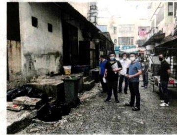
■商业中心后巷的非法建筑物已完全遮盖沟渠，左2是李文彬，左4是丘钦瀚。
